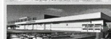
集出荷・貯蔵・加工施設の整備
