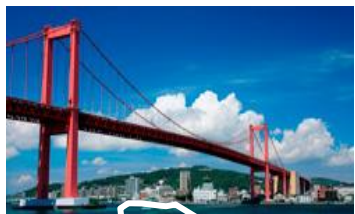
若松と戸畑を結ぶ若戸大橋
